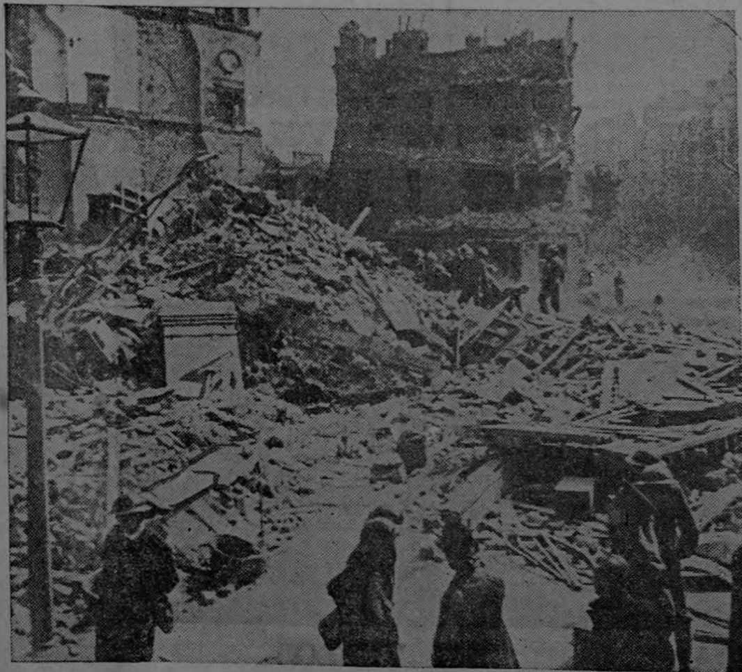
Casi todos los lectores de periódicos estarán familiarizados con fotografías como ésta. La vemos aquí para dar una idea de los daños causados por bombas alemanas en la capital inglesa. Los bomberos extraen cadáveres de los escombros. (Foto de la International Illustrated News).
